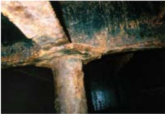
Photo.5 暴露甲板下の腐食
